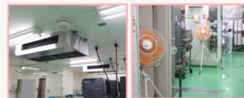
仕切りの無い厨房内で冷たい食事を盛り付けるNCC運用では、空調管理が最重要。空調機を5か所追加し、さらに空気循環を考え**扇風機を複数台設置**しています
