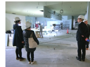
工場建設中(加熱調理室)
